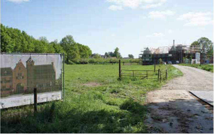
Bouwtterrein 2023, herbouw van Palmesteyn
